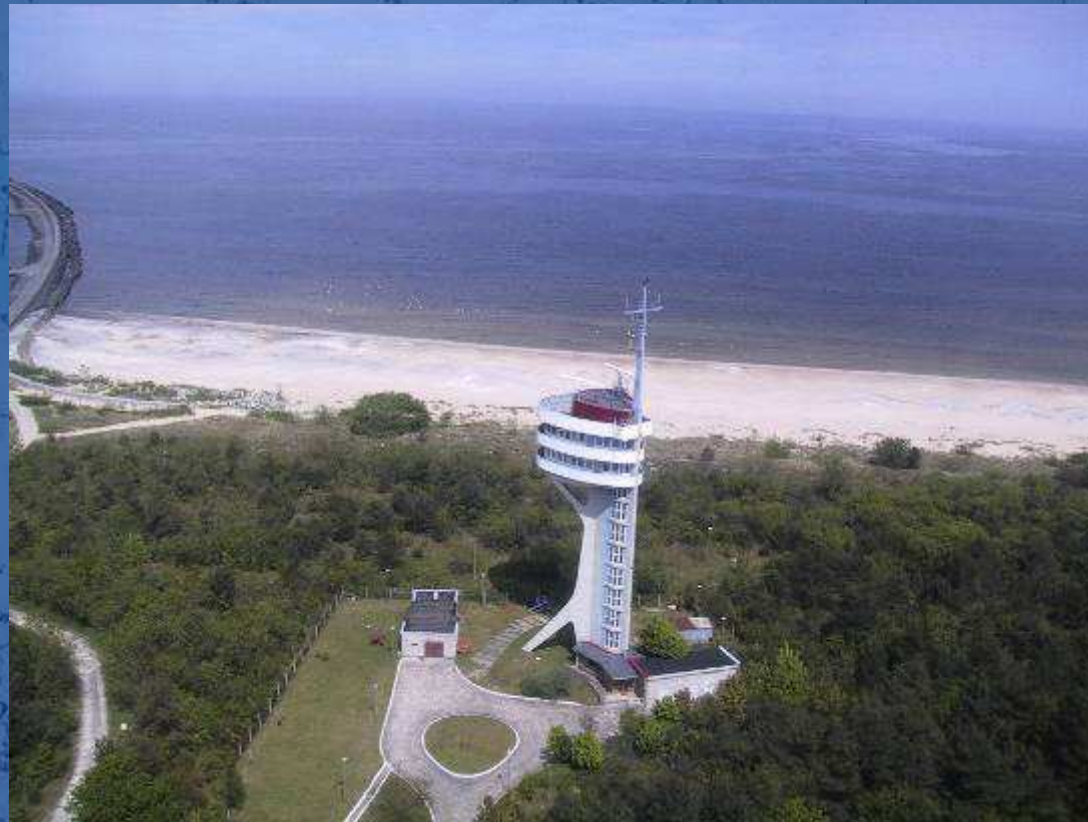
Widok ogólny obszaru inwestycji (stan obecny)
