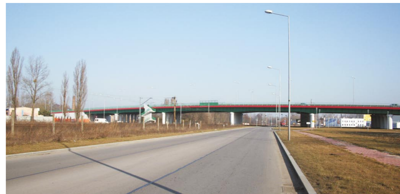
Zdjęcia na stronie: Projekt nr SPOT/2.2/61/04 Usprawnienie przejazdu w południowym korytarzu tranzytowym w Częstochowie
