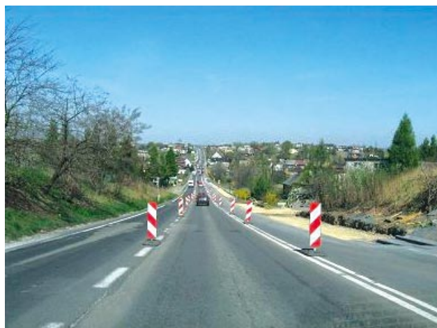
Zdjęcia na stronie: Projekt nr SPOT/2.2/65/04 Usprawnienie ruchu tranzytowego przez przebudowę Drogi Krajowej nr 78 na odcinku przebiegającym przez Miasto Rybnik
