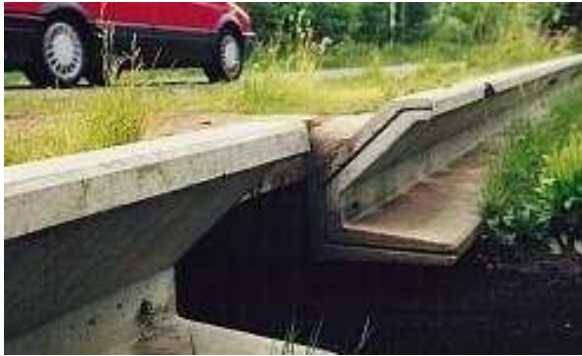
Zdjęcie 32. Przepust dla płazów wraz ze specjalnymi krawężnikami uniemożliwiającymi wtargnięcie płazów na drogę
