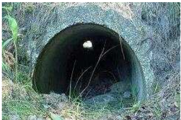
Zdjęcie 30. Przejście dla małych zwierząt
