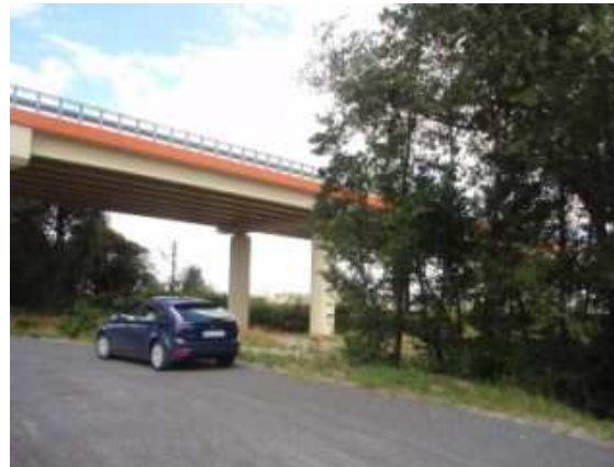
Zdjęcie 36. Przejście w Opolu zintegrowane z linią kolejową i drogą techniczną
