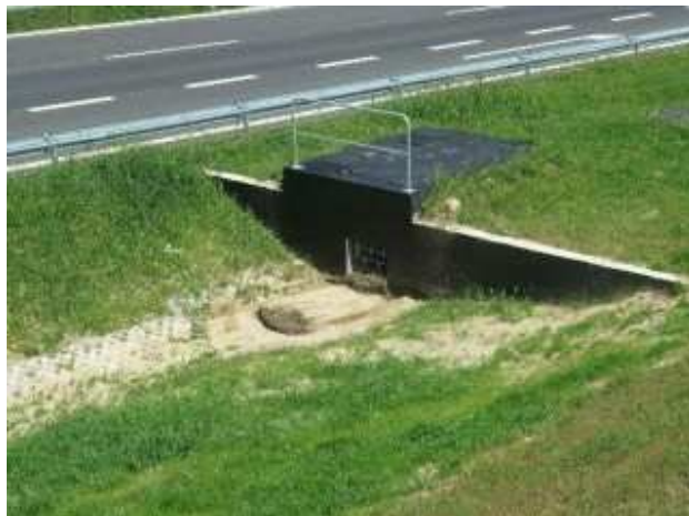
Zdjęcie 37. Niezabezpieczony odpowiednio wlot do kolektora – zagrożenie dla płazów i małych ssaków
