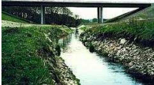
Zdjęcie 34. Przejście pod estakadą, wiaduktem, pod mostem
