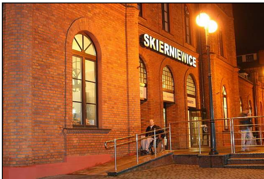
Fotografia 25. Otoczenie dworca w Skierniewicach jest przyjazne, ale brakuje poręczy z jednej strony pochylni.
