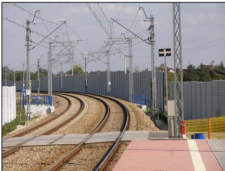
Fotografia 11. Na linii łódzkiej w niektórych miejscach postawiono ekrany akustyczne (na zdjęciu widok z przystanku Dąbrowice Skierniewickie)...
